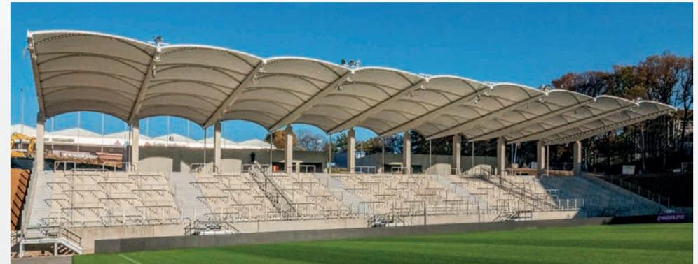
Auf einem Hochleistungsmaterial wie der vinylbeschichteten Polyester-Membran von Mehler Technologies kann man bedenkenlos in luftiger Höhe gehen, obwohl nur rund 1 mm Material-Stärke zwischen der Person und dem Abgrund liegen.
