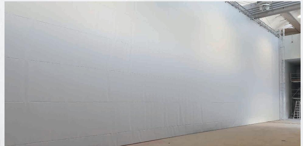
Um negative Umweltauswirkungen zu vermeiden, wurde im Labor für Agroforst-innovationen der Freien Universität Bozen, Italien, ein neuer Windkanal installiert, der aus einer Kombination von motorgetriebenen Doppelwand- und manuellen einwandigen Trennvorhängen besteht.
