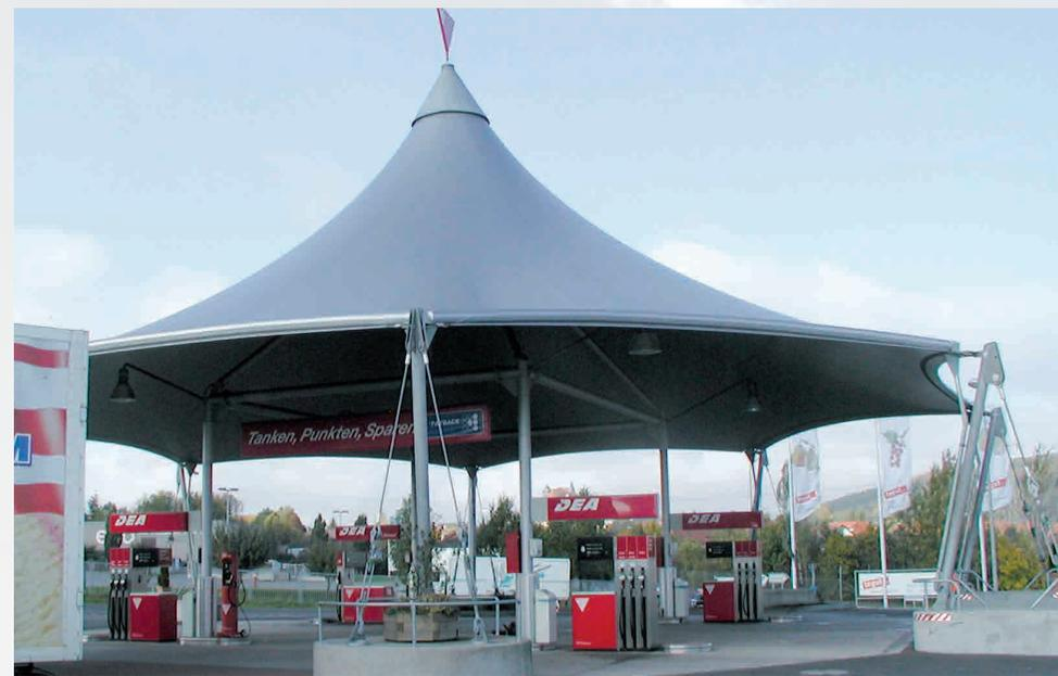
Auch die Tankstelle in Petersberg hat eine silberne Überdachung. Sie besteht nur aus einer Schicht der Mehler Technologies-Membran **VALMEX® FR 1400 MEHATOP® F metallic Type IV**, da keine thermischen
